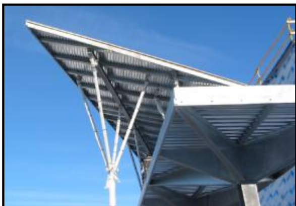
Structure pour marquise, halte routière, Québec
