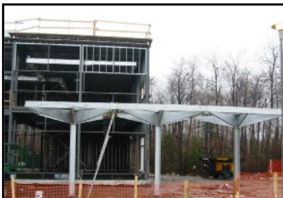
Structure pour marquise, halte routière, Québec
