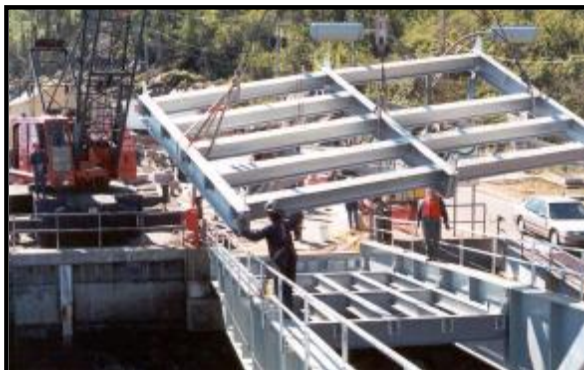
Structure de pont, Tadoussac, Québec
