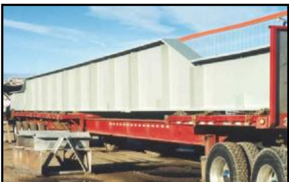
Structure de pont, Tadoussac, Québec
